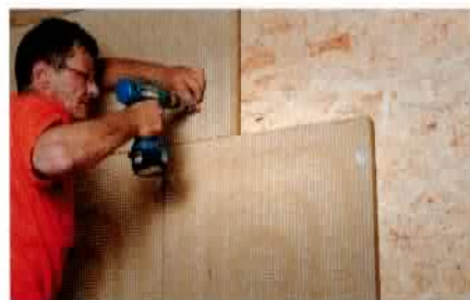
También puede instalarse sobre superficies preexistentes aplicando adhesivo y fijación mecánica.
