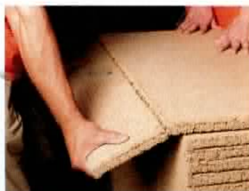
Los paneles se cortan fácilmente con herramientas habituales de la construcción en seco.
